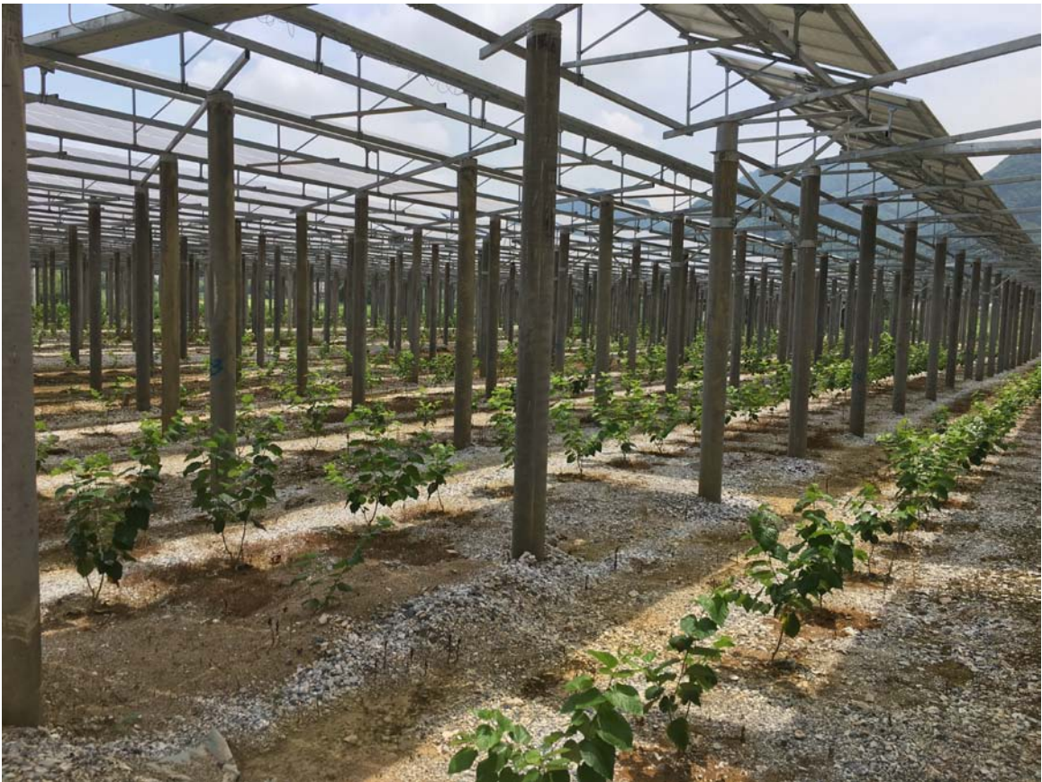
图 4.2-5 光伏阵列区人工植被绿化区，植被生长良好
