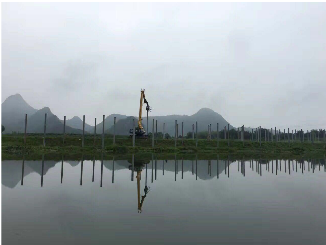
图 4.2-2 光伏阵列区支撑桩施工，地表植被基本不会被破坏，保持完好
