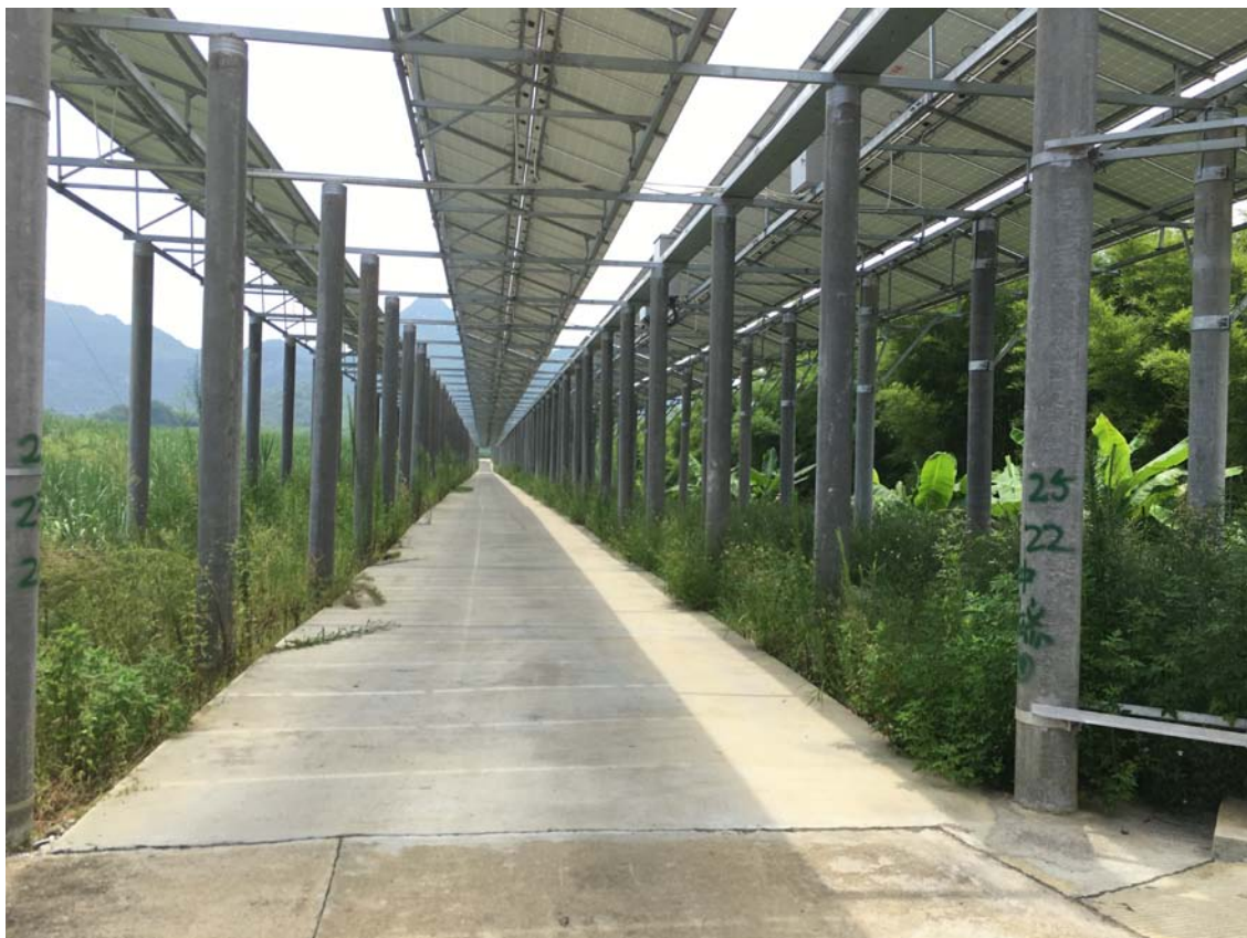
图 4.1-2 检修道路混凝土硬化路面区 1（升压站至县道 X407 段）
