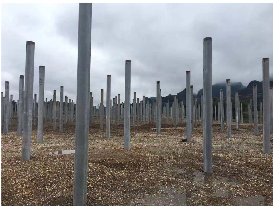
图 4.2-3 光伏阵列区子块 4 及子块 5 区场地平整，用碎石铺面
