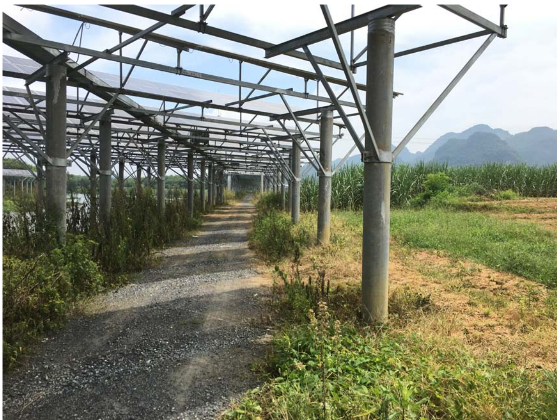
图 4.1-4 检修道路石渣硬化路面区
