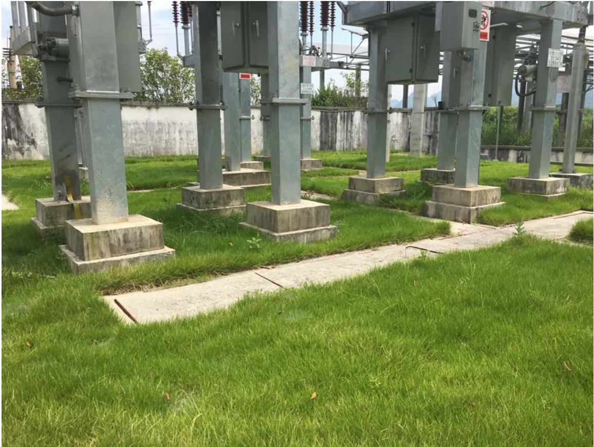
图 4.2-1 升压站植物绿化措施
