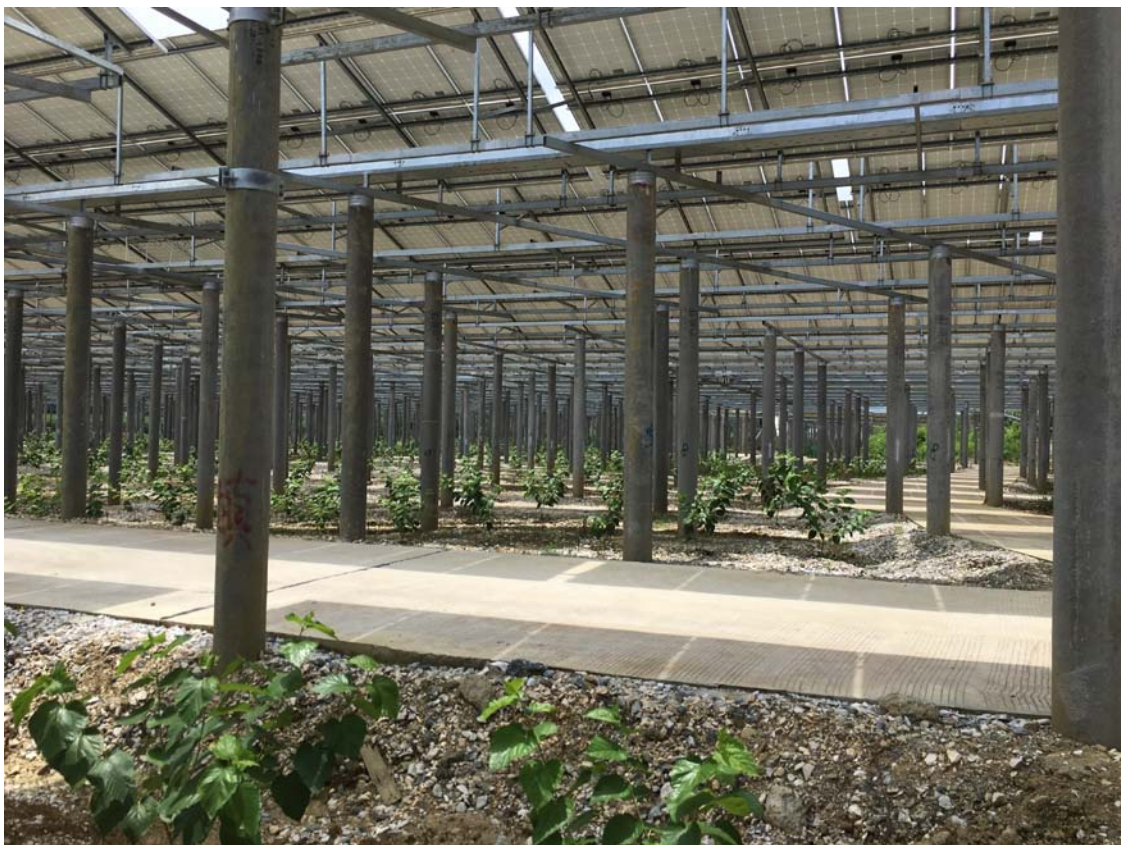
图 4.1-3 检修道路混凝土硬化路面区 2（子块 4 及子块 5 区）
