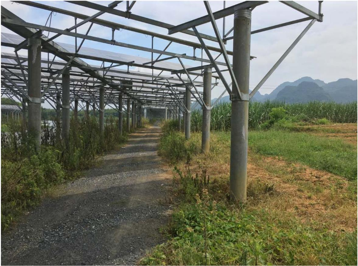
图 8 检修道路，石渣路面
